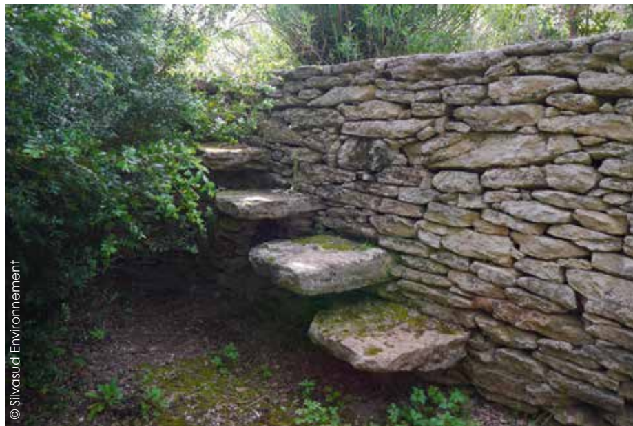
Pour des escaliers suspendus, il s'agit d'enfoncer de grands blocs de pierre de deux tiers de leur longueur dans le mur, participant alors à la structure de l'ouvrage.
