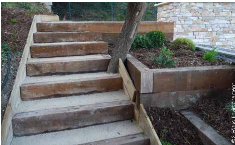
Pour le remplissage des marches, du gravillon concassé 16/22 a été installé puis damé. Cette finesse de granulométrie permet une descente agréable et sécurisée pour l'utilisateur.
