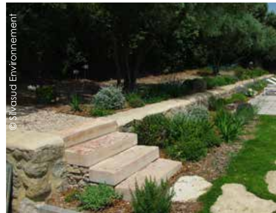
Pour un confort d'utilisation, le nez de marche doit être retravaillé afin d'éviter les blessures aux talons ou aux tendons. L'arête de la marche (en pierre, en bois...) peut être taillée/sciée en biais pour adoucir/polir les angles.
